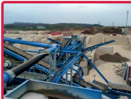
Extracción de las piedras
