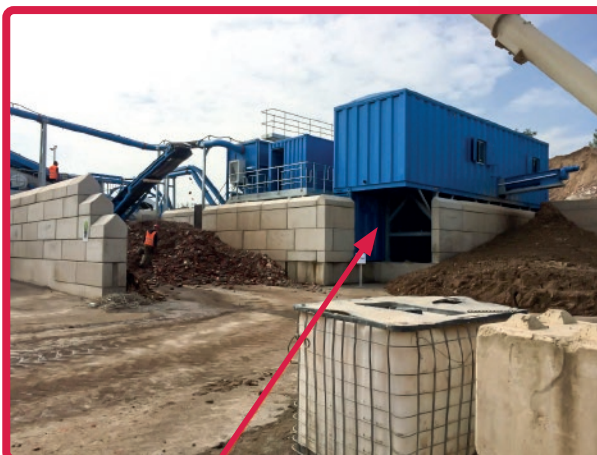
Aquí se instaló la planta de prueba en campo.
